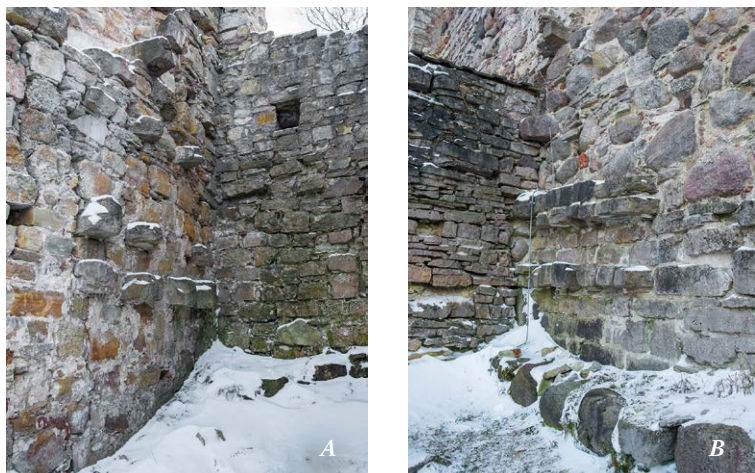
2. att. Mūra izvirzījumi (t. s. “zobinājumi”) jauna mūrējuma pievienošanai. A – ziemeļu tornis, B – rietumu tornis K. Kurcena foto, 2017
