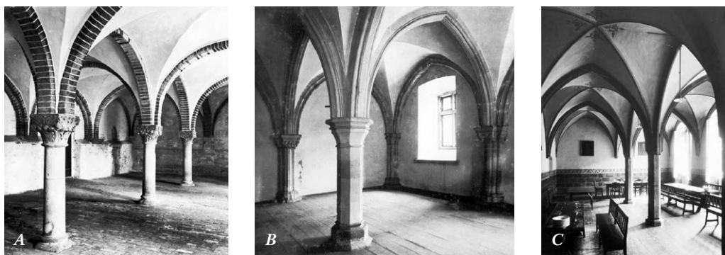
13. att. Velvju sistēmas, kur apvienotas gludas šķautnes un profilētas šķirējarkas. A – Jerihovas klosteris Vācijā, B – Hamelinas klosteris Vācijā, C – Sv. Nikolaja klosteris Bernkastelē-Kisā Vācijā (www.bildindex.de)
