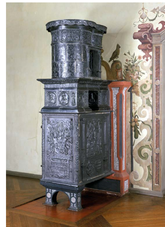
3. att. Čuguna krāsns ar mūrētu māla podiņu augšdaļu Vilhelmsburgas pili Šmalkaldē ( http://www.bildindex.de/document/obj20086612?part=0&medium=fmc429767 )
