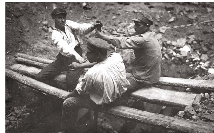
3. att. Tranšeja Nr. 6. Pazemes eju meklēšanā strādnieki liek lietā zemes urbi. (NKMPA, 1399-78-KM, 16)
