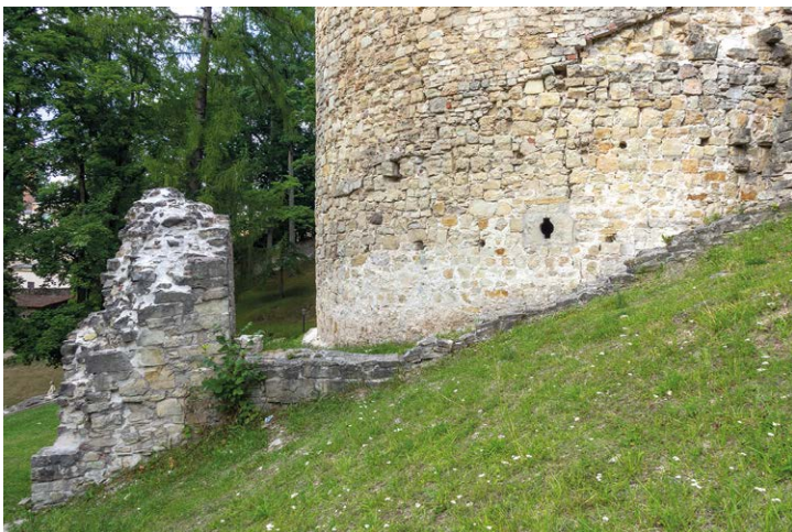
5. att. Skats uz ziemeļu torņa apakšdaļu un danskera balsta atliekām. Torņa sienā ir atjaunota šaujamlūka.
