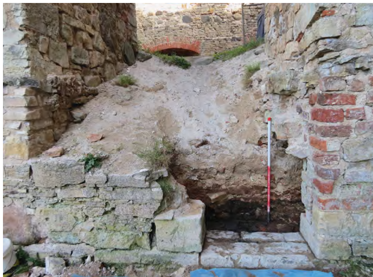
8. att. Hipotētiskā ieeja austrumu korpusa siltgaisa krāsns kurināšanas telpā L. Lēģeres foto, 2019
