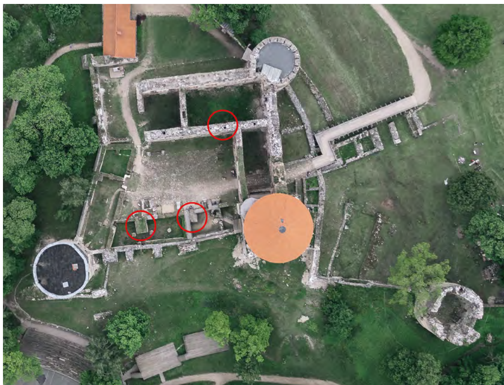
5. att. Cēsu pils kodola daļā konstatētās siltgaisa apkures krāšņu vietas
