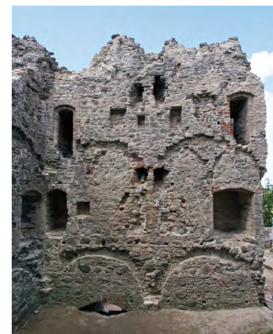
11. att. Austrumu korpusa ziemeļu daļas (dzīvojamo telpu) rietumu sienas kopskats. Sienas vidusdaļā – četri dūmkanāli un apkures ierīču vietas A. Opoļska foto, 2017
