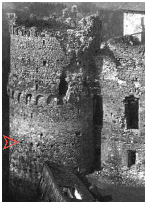
13. att. Skats uz D torni no austrumu puses 19. gadsimta beigās. Norādīta sastatņu lielāko balsta koku josla Foto no T. Pumpuriņa kolekcijas
