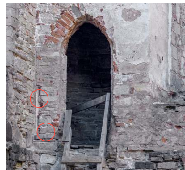
18. att. Ieeja D tornī no A korpusa, domājams, izveidota ap 1540. gadu. Sākotnējā aila ar akmens aplodu atradusies tuvāk telpas stūrim. Norādīta senākās ailas mala un sliekšnis
