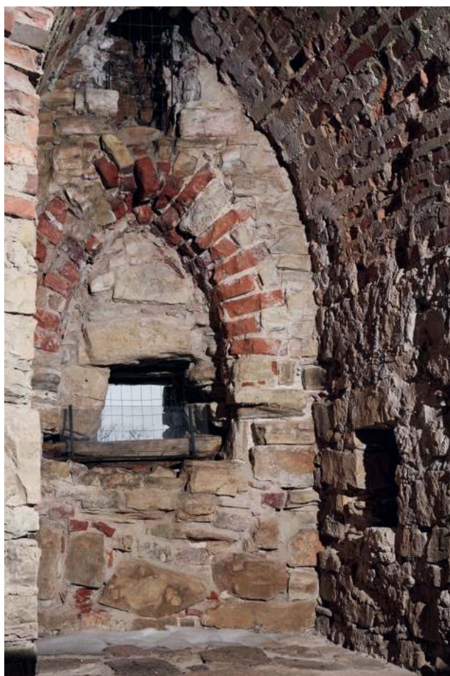
22. att. Šaujamlūka L4-13 ar vēdināšanas kanālu L4-14. Lūkas arkas cekulā bijis iestrādāts metāla stienis. Saglabājies ieroča balsta koks A. Opoļska foto, 2021
