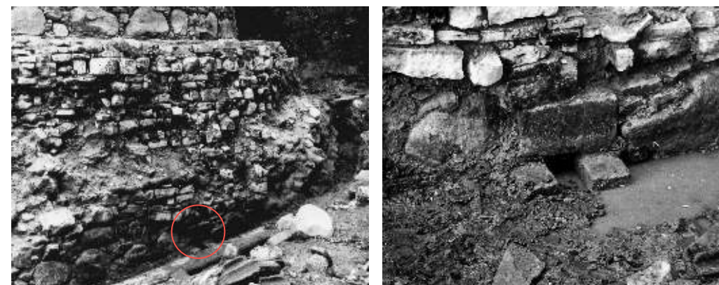
4. att. 1984. gadā atsegtais D torņa pagraba caurteces kanāla izvads pilsgrāvī (Apala 1984)
