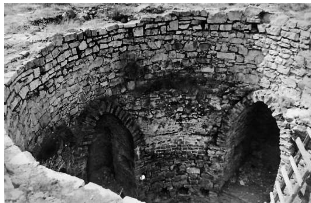
23. att. Skats uz torņa ceturtā stāva šaujamlūkas velvē, kādas tās izmūrēja 20. gadsimta 30. gados. Starp šaujamlūkām redzamas velves ķieģeļu atliekas un grīdas siju vietas. Siena virs šaujamlūkām pārmūrēta 1938. gadā T. Čiparsona foto, 1958
