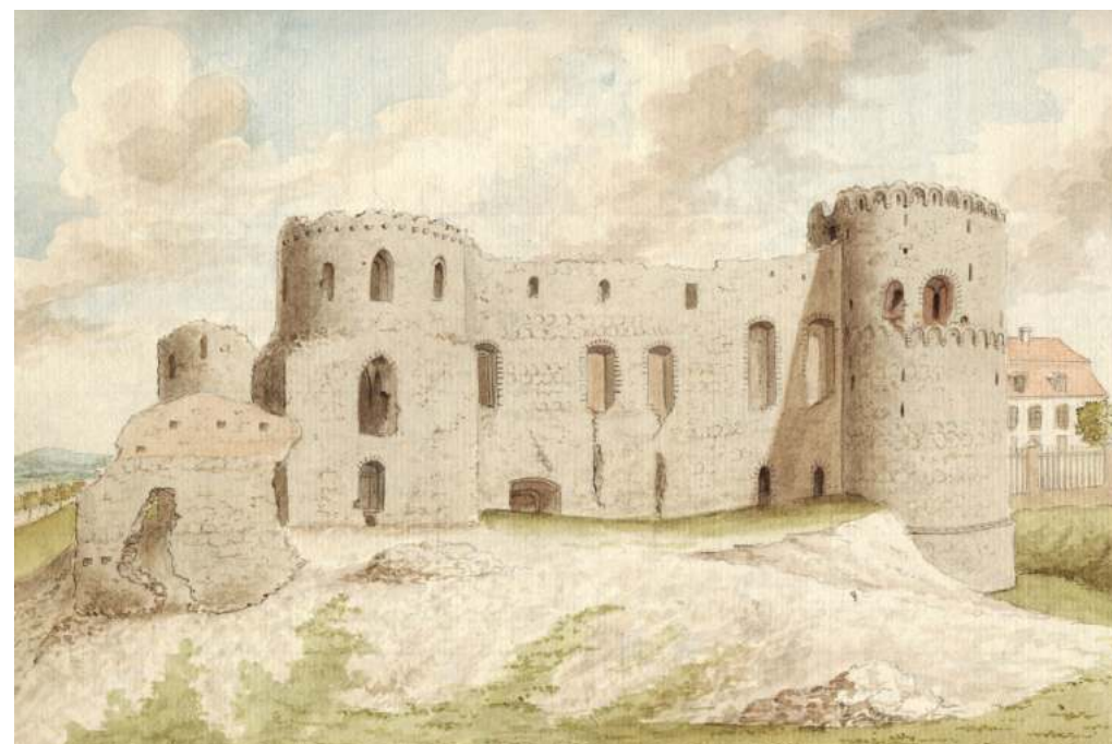
1. att. Skats uz Cēsu pili no dienvidu puses. D tornim redzami ārsienas nobrukumi (LUAB, BM05124A)
