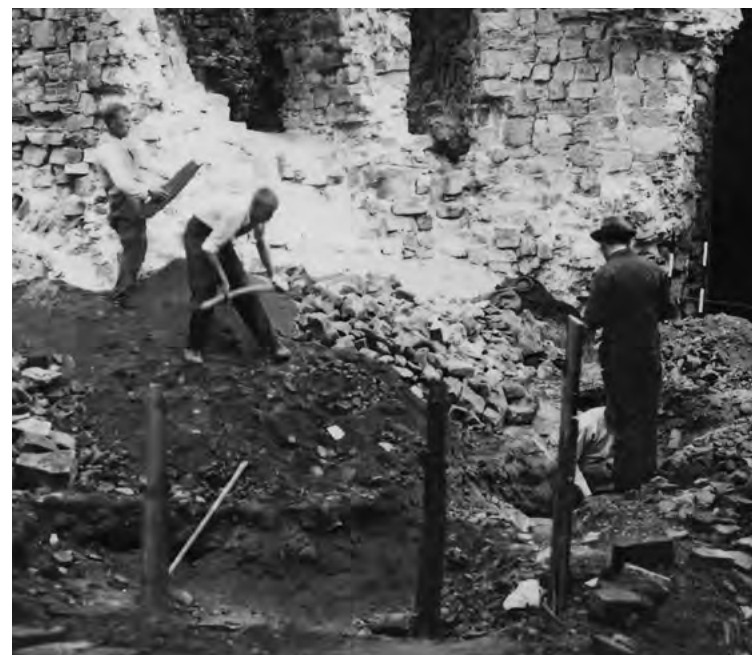
2. att. Izrakumi ziemeļu korpūsā (izrakumu laukums Nr. 2). Rakšanas darbu uzraudzību nodrošina Pieminekļu valdes inspektors Arturs Štāls NKMP KMIC, 6203: 5614, 5
