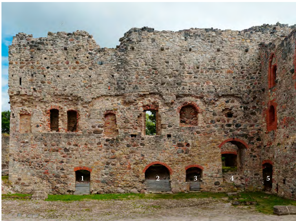
5. att. Austrumu korpusa pagalma fasāde ar restaurācijas darbos pārveidotām durvju ailām pirmajā stāvā. Lielākā aila (4) izveidota 20. gadsimta 30. gados hipokausta apkures krāsns konstrukciju zonā. Šeit bijusi neliela ieeja hipokausta kurināšanas telpā.
