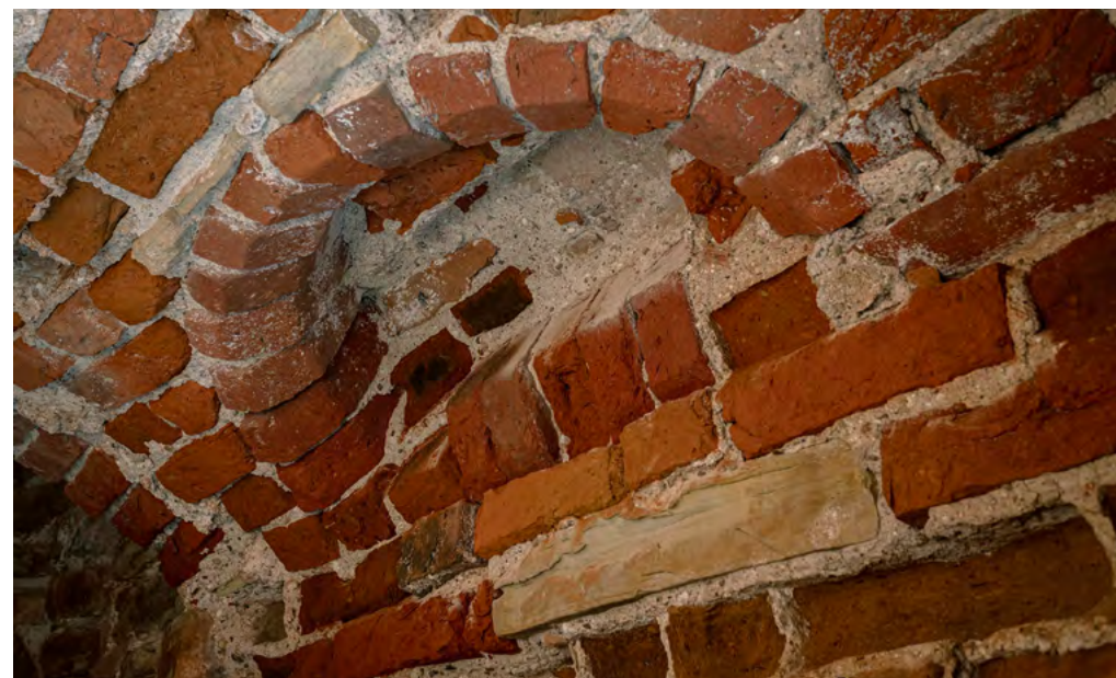
3. att. Viduslaiku arhitektūras pieminekļu izpētei allaž paliek daudzi neatrisināti jautājumi. Rietumu torņa pagraba telpa, eja uz vītņu kāpnēm. Nezināmas nozīmes augšup vērsta aila, kas vēlāk aizmūrēta
