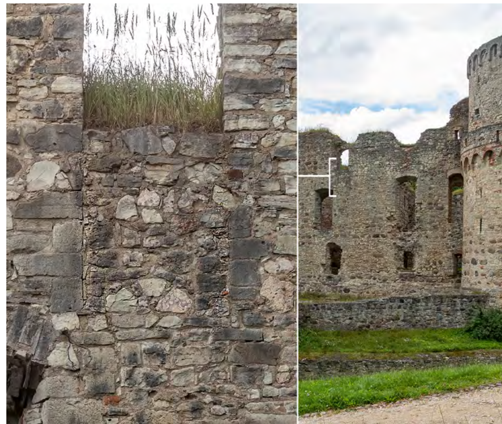
7. att. Galvenās pils dienvidu fasādē starp otro un trešo stāvu ir redzama aizmūrēta nezināmas nozīmes aila
