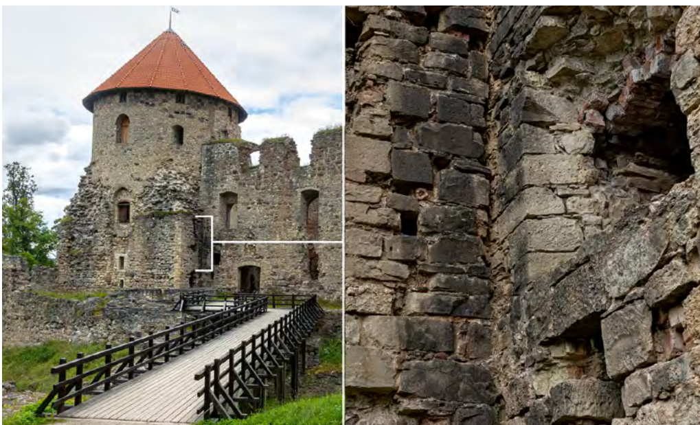
2. att. Rietumu tornis piebūvēts pie galvenās pils dienvidu fasādes. Atsākot pils būvēstures izpēti, šis acīmredzamais fakts radīja virkni jautājumu un rosināja pārskatīt līdzšinējo pils korpusu periodizāciju un būvniecības secību
