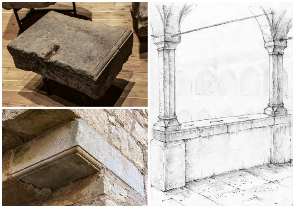
17. att. Dažādās vietās Cēsu pili atrastās akmens detaļas ar profilētu šķautni, domājams, nosegušas pagalma galerijas sienas virspusi
