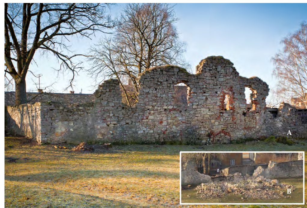
14. att. Priekšpils dienvidu sienas fragments 2014. gada februārī (A) un pēc sagrūšanas tā paša gada martā (B)
