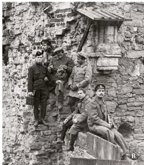
11. att. 1914. gadā Cēsu pilsdrupās veikti arī citi praktiskās saglabāšanas darbi, piemēram, atjaunots dienvidu korpusa ārsienas fragments (A) un virs kapelas konsoles izbūvēts dēļu jumtiņš (B)
