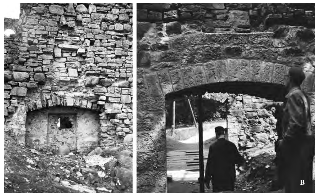
39. att. Dienvidu korpuse vārtu aila pirms (A) un pēc (B) 50. gadu otrajā pusē veiktās restaurācijas. Atjaunošanas darbi īstenoti saskaņā ar arhitekta Ojāra Treigūta 1956. gadā sagatavotiem darba zīmējumiem (NKMP KMIC, inv. Nr. 1292–1924, AR-14–16). Ailā bija plānots ievietot koka vērtņi ar kaltām virām (NKMP KMIC, inv. Nr. 1300, AR-22) A – NKMP KMIC, Fn 14726; B – INA, ERA, T-76.1.N-3350-4
