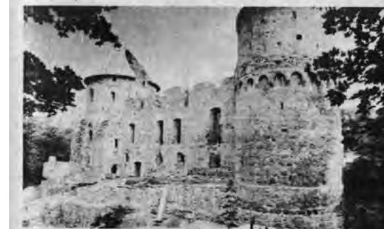
Attēlā: «Rāmavas» darba objekts, priekšplānā atjaunojamais mūris, redzams arī nepabeigtais jumta segums.
