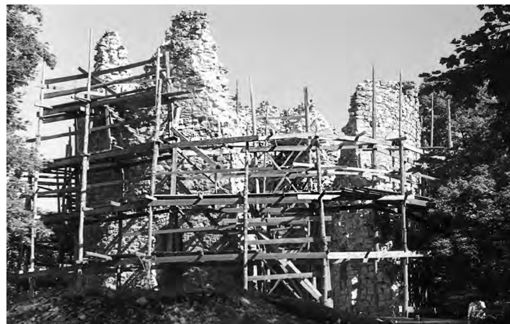
42. att. Ziemeļu tornis restaurācijas darbu laikā. 1962. g. NKMP KMIC, Fn 11383
