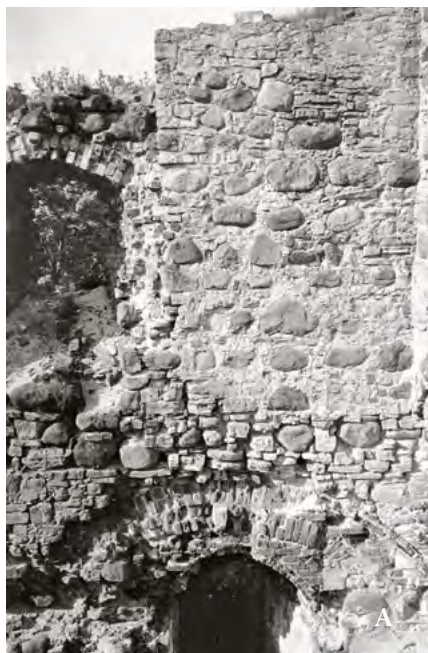
11. att. 1914. gadā Cēsu pilsdrupās veikti arī citi praktiskās saglabāšanas darbi, piemēram, atjaunots dienvidu korpusa ārsienas fragments (A) un virs kapelas konsoles izbūvēts dēļu jumtiņš (B)
