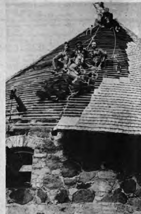
Attēlā: darba vieta uz jumta 35 metru augstumā.
