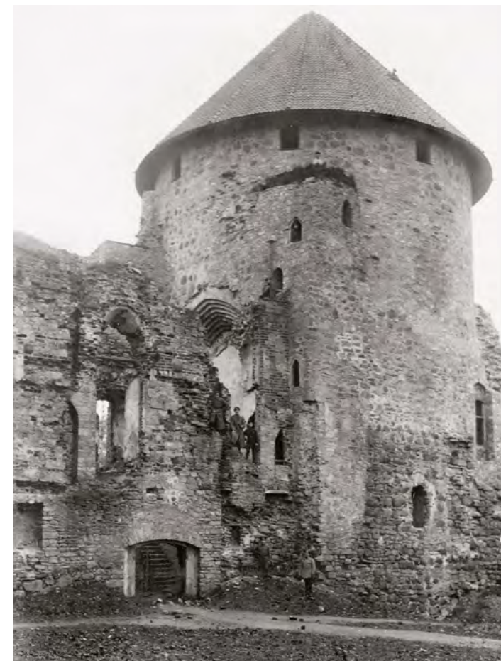
12. att. Rietumu tornis 1917. gadā. Redzams, ka kāpņu torniņa virsplakne konservācijas nolūkā nosepta ar velēnām INA, EFA.124.A.122.161
