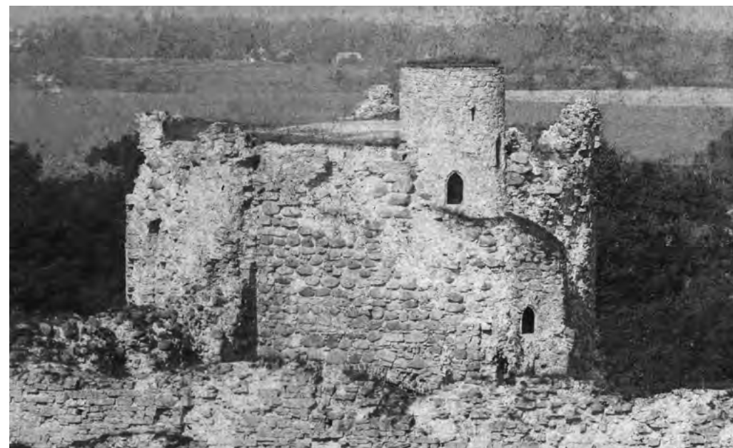
2. att. Rietumu torņa augšējā daļa 19. gadsimta 90. gados. Redzams no torņa pamatapjoma izvirzītais cilindriskais kāpņu tornītis, no kura varēja nokļūt uz torņa augšējās plaknes – skatu platformas CM 119022, 4. lpp.
