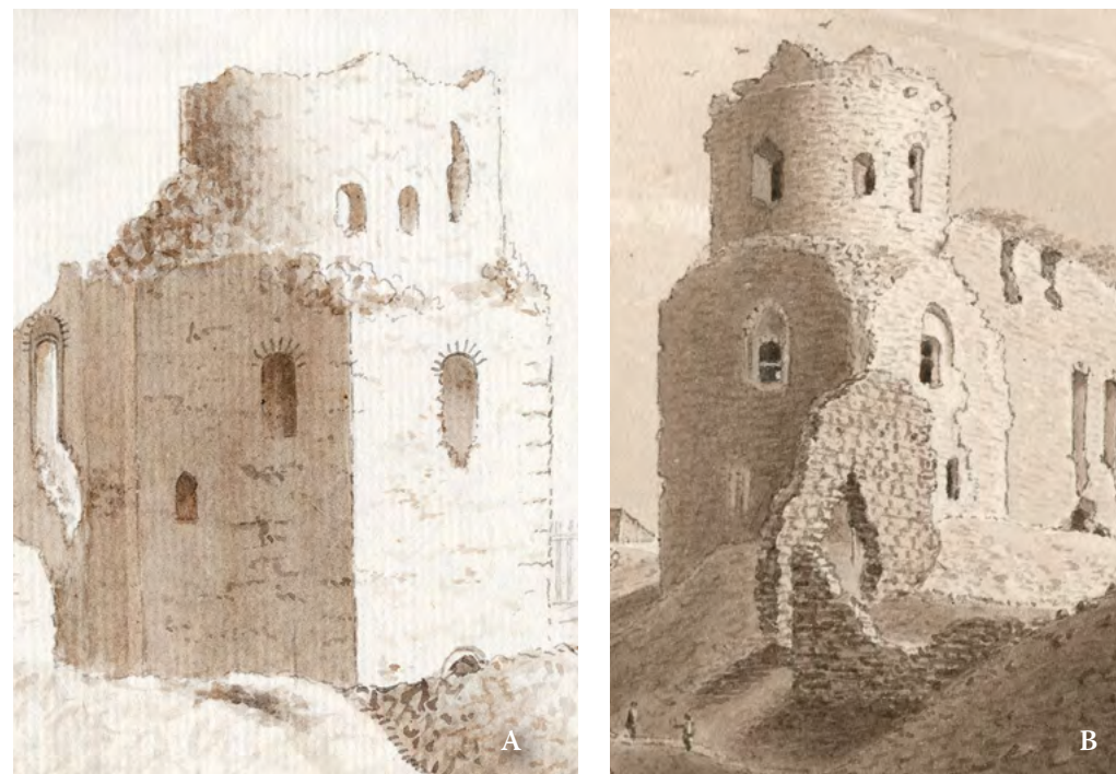
6. att. Rietumu tornis 1793. gadā (A) un 1810. gadā (B). Laikā, kas šķir abus attēlus, veikta otrā stāva telpas logailu pārveidošana A – LUAB, BM05119A; B – IVM, 7614 G 1381
