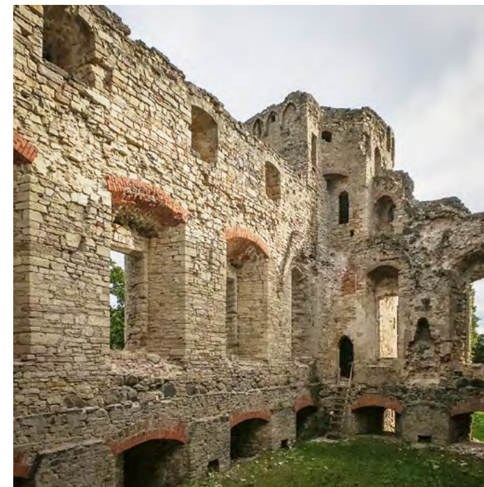
34. att. 20. gadsimta 50. gados veikto atjaunošanas darbu gaitā izlīdzināta austrumu korpusa austrumu fasādes plakne, t. sk. aizmūrētas visas sastatņu ligzdas, kas bija izveidojušās pēc sienas būvniecībai izmantoto sastatņu gulšņu demontāžas. Salīdzinot fotoattēlus, kas uzņemti pirms (A) un pēc (B) atjaunošanas darbiem, labi novērtējams papildinājumu apjoms sienas augšdaļā A – NKMP KMIC, 6203: 1406-55, 1; B – NKMP KMIC, Fn 2666
