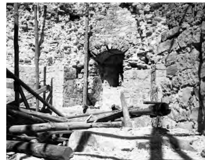
44. att. Ziemeļu torņa otrā stāva telpa 1964. gadā. Abpus loga nišai redzams atjaunotais sienas čaulas mūrējums NKMP KMIC, Fn 14366
