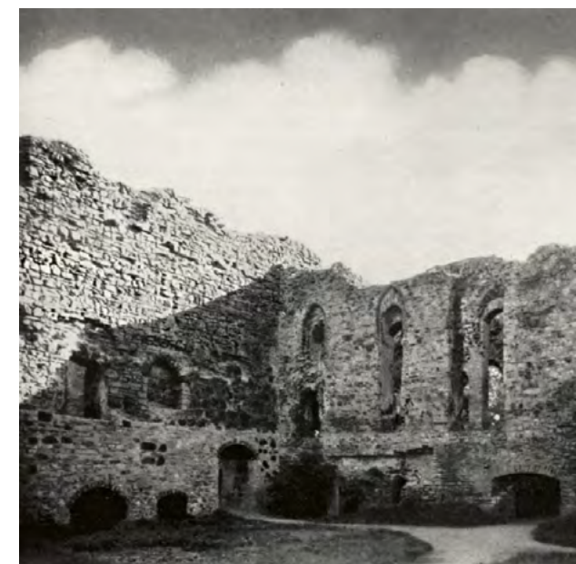
23. att. 1939. gadā publicētajā fotoattēlā redzams nesen atjaunotais austrumu korpusa pagalma sienas apakšējās daļas mūrējums Clasen 1939, 447
