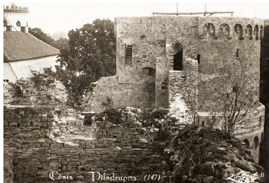
19. att. Dienvidu tornis skatā no rietumiem pirms (A) un pēc (B) fasādes restaurācijas A – CM 119022, 14. lpp.; B – T. Pumpuriņa kolekcija
