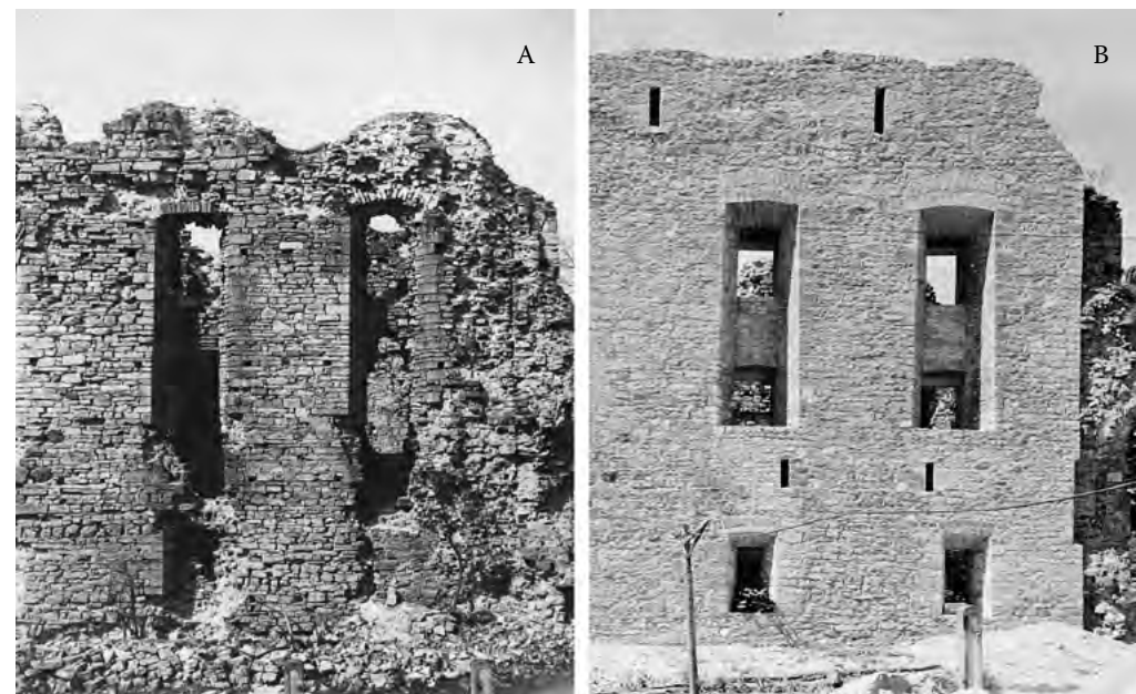
34. att. 20. gadsimta 50. gados veikto atjaunošanas darbu gaitā izlīdzināta austrumu korpusa austrumu fasādes plakne, t. sk. aizmūrētas visas sastatņu ligzdas, kas bija izveidojušās pēc sienas būvniecībai izmantoto sastatņu gulšņu demontāžas. Salīdzinot fotoattēlus, kas uzņemti pirms (A) un pēc (B) atjaunošanas darbiem, labi novērtējams papildinājumu apjoms sienas augšdaļā A – NKMP KMIC, 6203: 1406-55, 1; B – NKMP KMIC, Fn 2666
