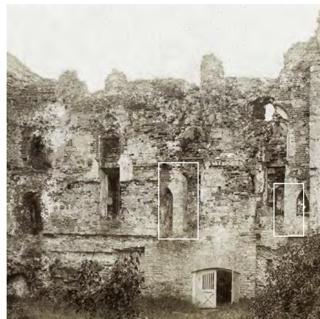
3. att. Dienvidu korpusa pagalma siena. Ap 1890. g. Norādītas Karla Gustava fon Ziversa laikā izveidoto mūra balstu atrašanās vietas CM 119022, 6. lpp.
