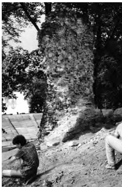
53. att. Mūra balsts ziemeļu torņa pakājē. Konstrukcija demontēta 1990. gadā NKMP KMIC, 6203: 1428-46-KM, 6. att.
