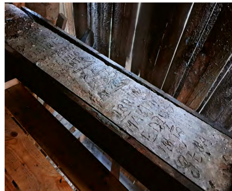
50. att. Torņa augšstāvā ārsienas fragmenti savstarpēji savienoti ar dzelzsbetona savilcēm. Uz vienas no tām nesacietējušajā betonā parakstījušies torņa atjaunošanā iesaistītie strādnieki G. Kalniņa foto, 2024
