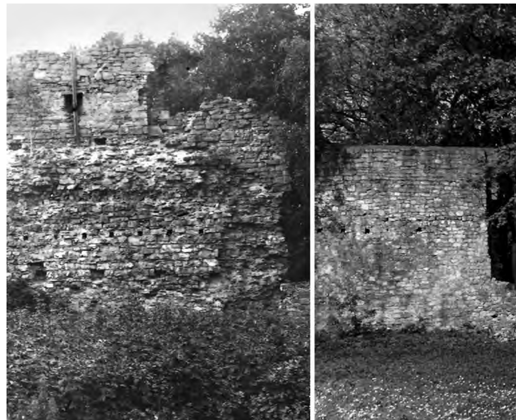
46. att. Bez jebkādas dokumentācijas 1968. gadā (?) veikta pirmās priekšpils apkārtmūra dienvidrietumu posma atjaunošana. Darbu laikā pārmūrēta sienas čaula un demontēti autentisko konstrukciju fragmenti sienas augšējā daļā CM KPA, bez inv. nr.
