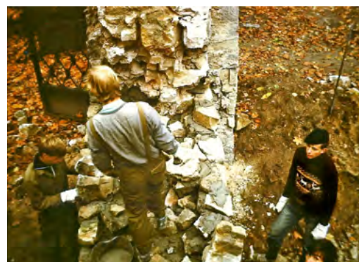
54. att. Izlauzuma aizmūrēšana pirmās priekšpils apkārtmūrī. 1990. g. Foto no U. Grinberga personīgā arhīva
