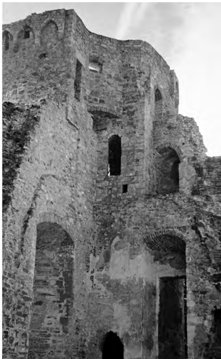
22. att. 20. gadsimta 50. gadu fotouzņēmumos redzams, ka dienvidu torņa fasādes restaurācijas laikā atjaunotas arī līdzās esošo korpusu sienu daļas un aillas NKMP KMIC, Fn 14749, 13787, 13841
