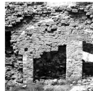
4. att. 19. gadsimta 30. gados izveidotie mūra balsti dienvidu korpusa austrumu daļā NKMP KMIC, Fn 13828
