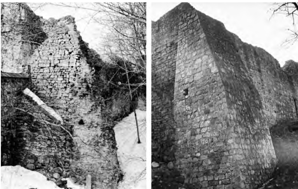
36. att. Par 13. gadsimtā celtās Cēsu pils kapelas ziemeļu sienas un ziemeļaustrumu stūra kontrforsa sākotnējo mūrējumu šobrīd varam spriest tikai pēc dažiem 20. gadsimta pirmajā pusē uzņemtiem fotoattēliem. 1958. un 1959. gadā sienas čaula pārmūrēta bez izpētes, projekta un izpildedokumentācijas CM KPA, bez inv. nr.
