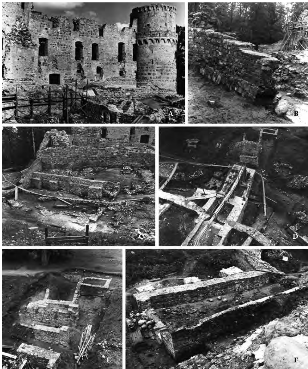
48. att. Arheoloģiskajos izrakumos Cēsu pils dienvidu pusē atsegto mūra konstrukciju konservācija A – 1979. gada oktobris: atjaunots tilta celtnes rietumu sienas čaulas mūrējums, pie dienvidu aizsarg-sienas piebūvētas sastatnes konservācijas darbu veikšanai; B – 1980. gada septembris: nostiprināts viens no tilta celtnes balstiem, turpinās dienvidu aizsargsienas konservācija; C – 1982. gada septembris: pabeigta dienvidu aizsargsienas konservācija, veikta grāvja celtnes ziemeļu sienas čaulas kārtas atjaunošana; D – 1983. gada septembris: noris tilta celtnes ziemeļu daļas un dienvidu aizsargsienas austrumu posma konservācija; E – 1984. gada septembris: pabeigta tilta celtnes dienvidu daļas konservācija; F – 1985. gada septembris: pabeigta grāvja celtnes dienvidu sienas konservācija NKMP KMIC, Fn 62476, 63491, 66227, 67633, 69405, 762268
