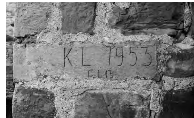
28. att. Austrumu korpusa pirmā stāva ailas L1-03 sānu malā iemūrēts akmens ar iekalumu “K.L. 1953. / C.L. 13.”. Iespējams, paraksta autors ir būvdarbu vadītājs Kārlis Laiders G. Kalniņa foto, 2024
