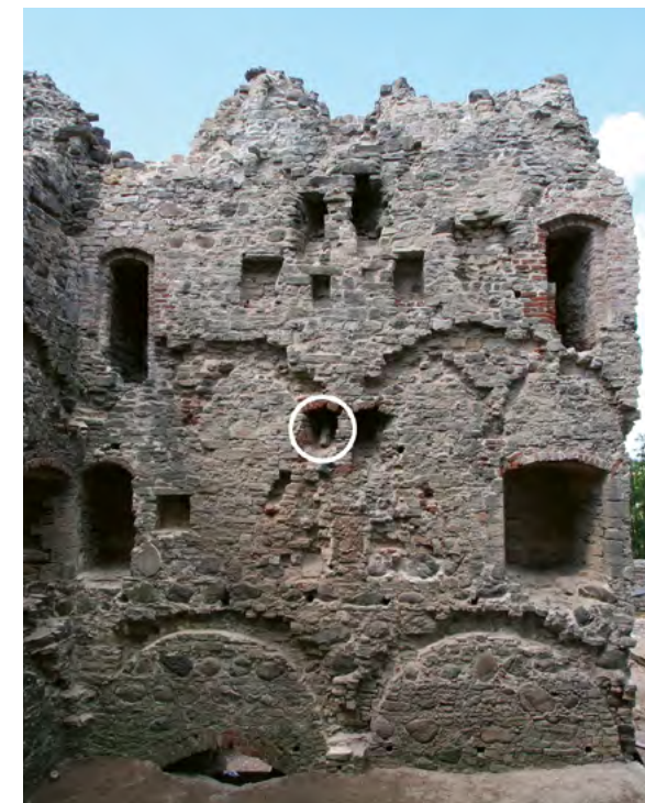
3. att. Austrumu korpusa rietumu puses sienas ziemeļu gals. Dūmvadā redzams koka uzspāres gals G. Kalniņa foto, 2008
