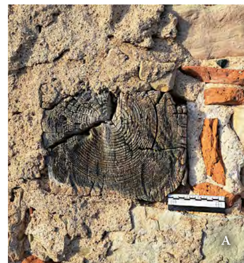
5. att. Sastatņu balsta elementi dienvidu torņa ārsienā (tuvplānā): A – elements Nr. 2, B – elements Nr. 3 G. Kalniņa foto, 2024
