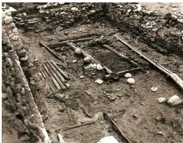
9. att. Koka konstrukciju paliekas aizsarggrāvja gultnes rietumu galā atsegtais ēkas teritorijā Apala 1984
