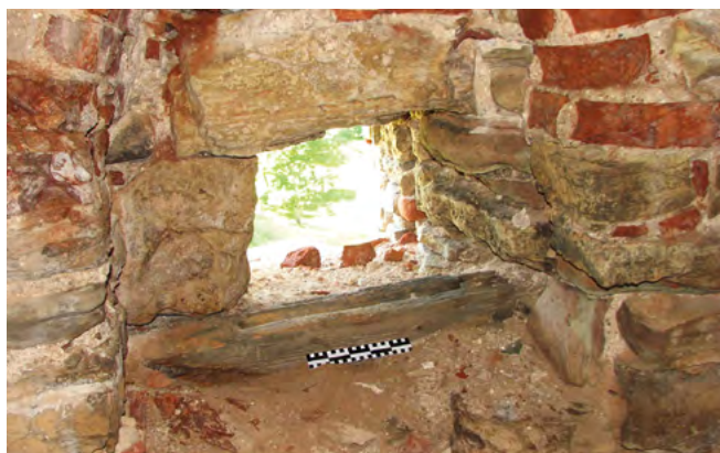
6. att. Āķu bises balsta koka paliktis dienvidu torņa ceturrtā stāva šaujamlūkā (L4-02) M. Zundes foto, 2013
