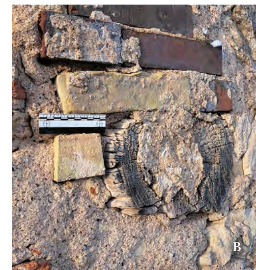
5. att. Sastatņu balsta elementi dienvidu torņa ārsienā (tuvplānā): A – elements Nr. 2, B – elements Nr. 3 G. Kalniņa foto, 2024
