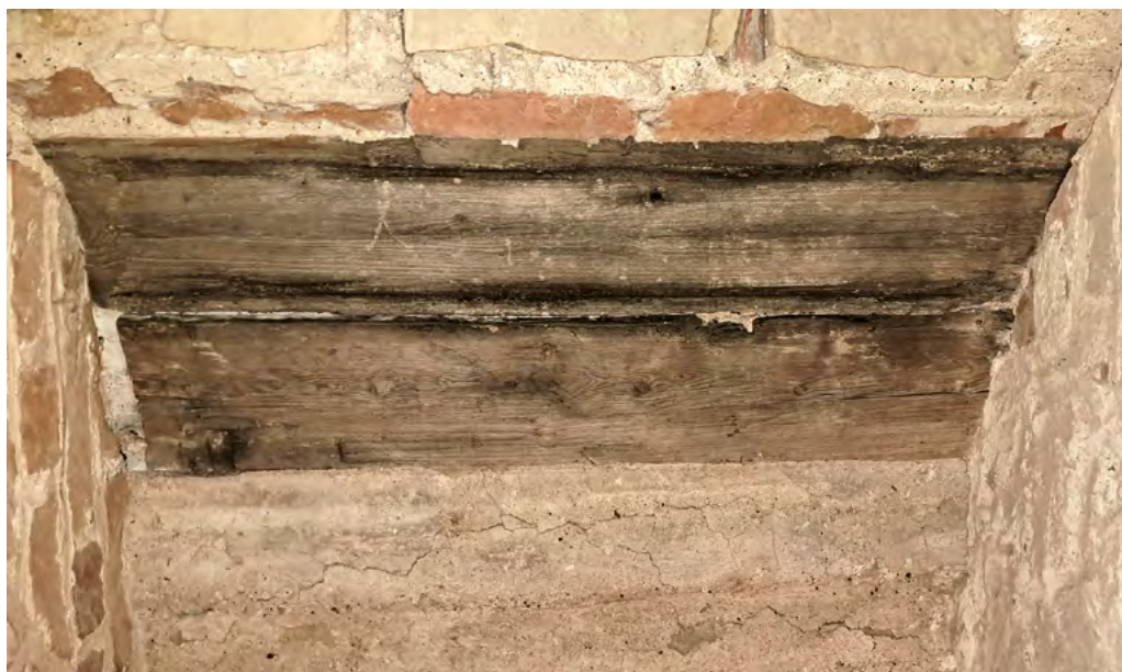
13. att. Velles mūrēšanas procesā izmantotie veidņu dēļi rietumu torņa pirmajā stāvā G. Kalniņa foto, 2024
