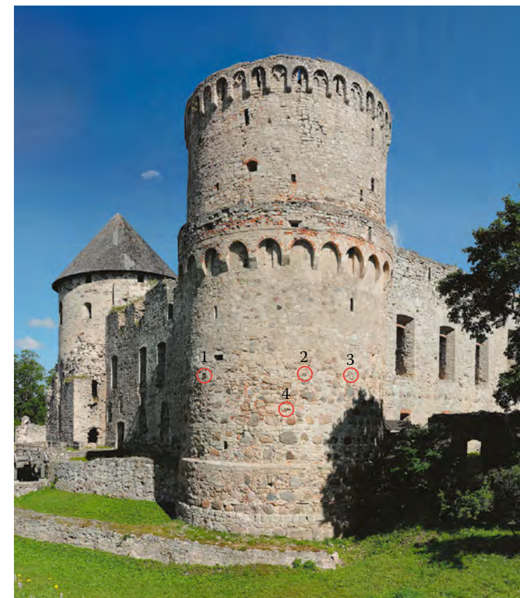
4. att. Rakstā minēto sastatņu balsta elementu atrašanās vietas dienvidu torņa ārsienā K. Kurcena foto, 2014
