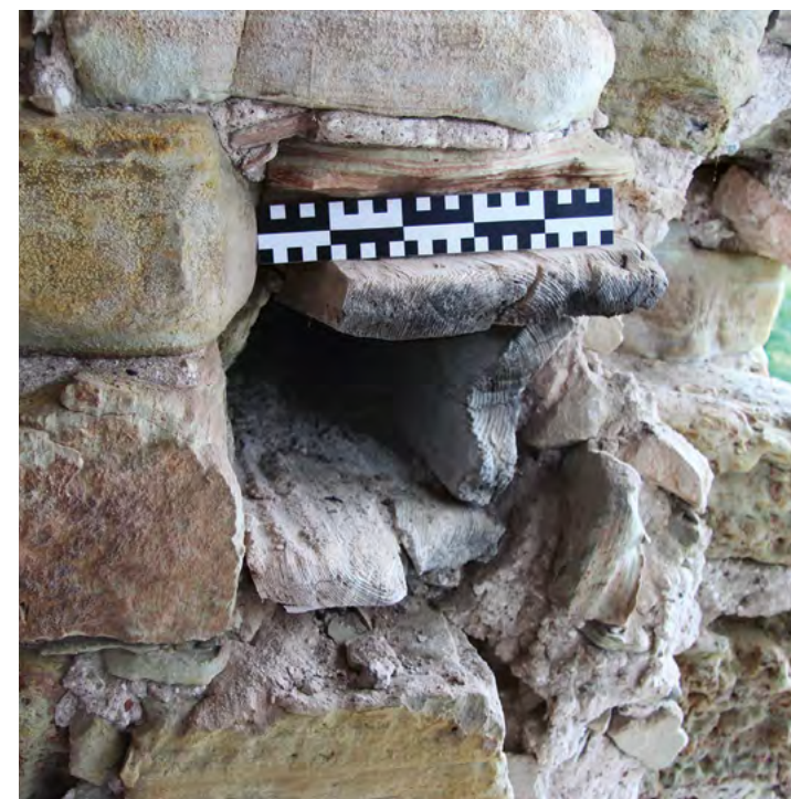
12. att. Ar dēļiem oderēta aizbīdņa ligzda priekšpils rietumu torņa sienā (pirms koksnes paraugu atzāģēšanas) G. Kalniņa foto, 2024
