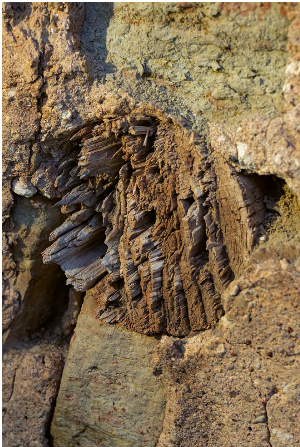
Sastatņu balsta elements Cēsu pils priekšpils rietumu torņa ārīnā. J. Vīksnas foto, 2024
