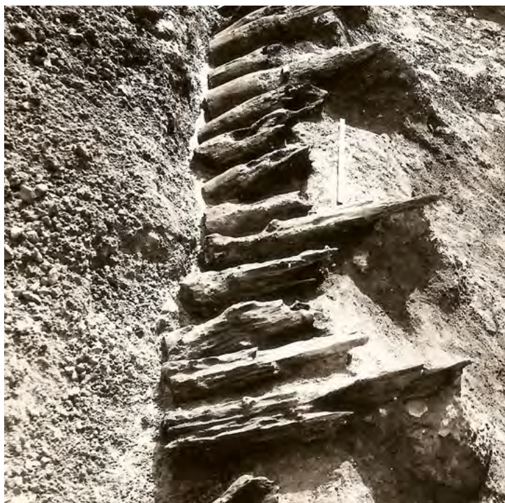
15. att. Nogāzes uzbēruma slāņa atbalsta stabu rindas posms M. Zundes foto, 1987
